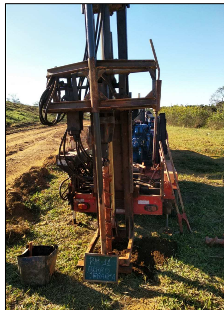
Foto 14 – Execução de sondagens para instalação de poços de monitoramento.
