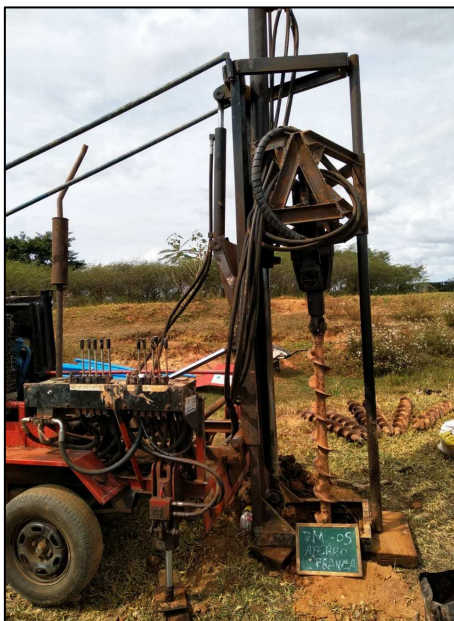
Foto 15 – Execução de sondagens para instalação de poços de monitoramento.
